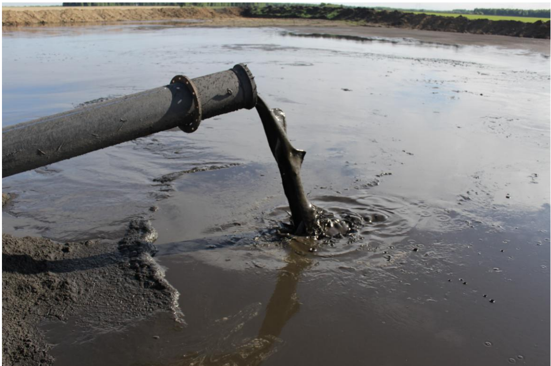
Рисунок 2.8 - Закачка сапропелевой гидросмеси в земляной чек-отстойник в Тюмени.
