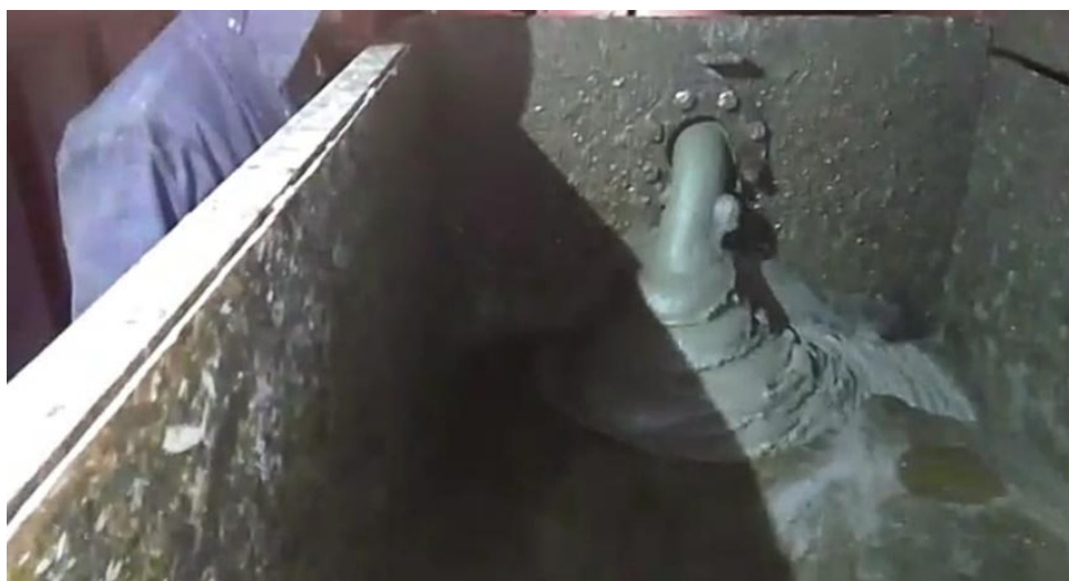
Рисунок 5.5 - Подача сапропеля естественной влажности с помощью ПГКК в приёмный бункер земснаряда для его дальнейшей транспортировки по напорному трубопроводу в береговой накопительный бункер сапропеля.
