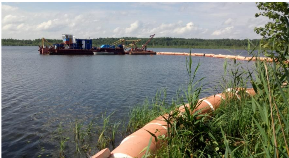
Рисунок 5.4 - Вид земснаряда на озере Савельево с плавающим пульпопроводом из резиноктаневых труб, обернутых поплавками
