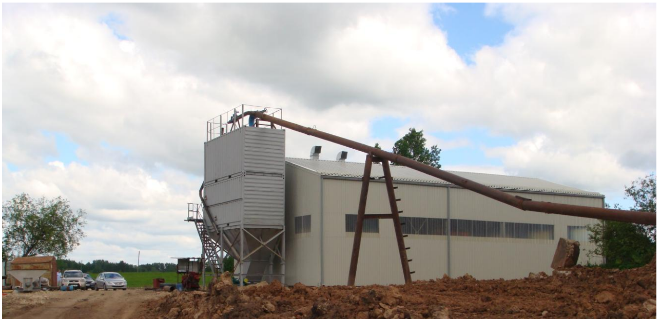
Рисунок 2.13 – Вид накопительного бункера сапропеля с подающим стальным трубопроводом на озере Пильвелю.
