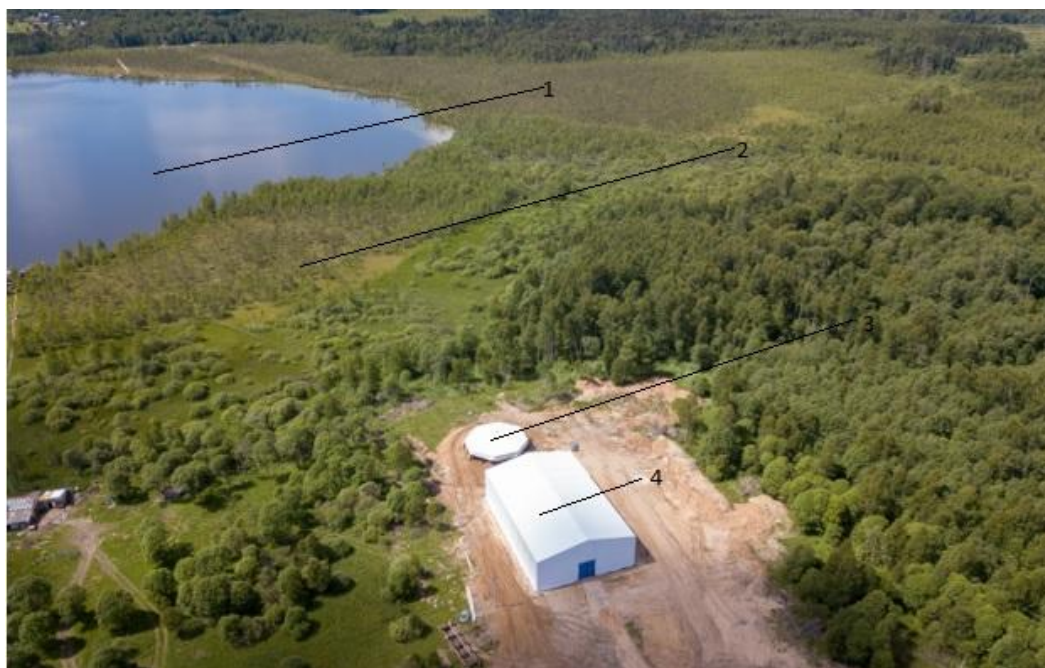
Рисунок 5.1 - Общий вид завода по производству торфо-сапропелевых смесей (ТСС): 1 – экологически чистое озеро Савельево, общая площадь 44 га; 2 – магистральный береговой пульпопровод; 3 – сборный ж/бетонный бункер сапропеля объёмом 500 м 3 ; 4 – тентовый ангар 24м x 36 м x 6м (h) для производства ТСС.
