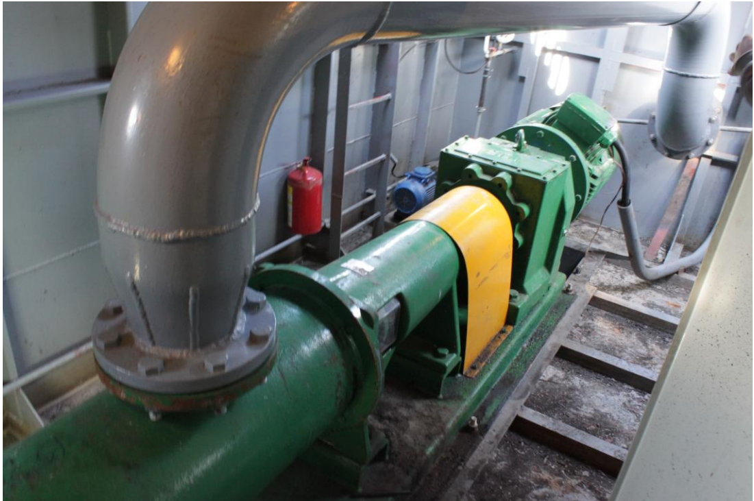
Рисунок 2.7 - Вид стандартного эксцентрикового винтового насоса, установленного в трюме земснаряда в Тюмени.
