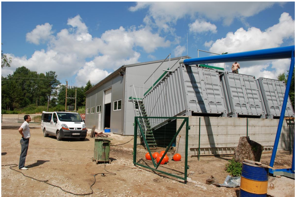
Рисунок 2.18 - Вид берегового бункера сапропеля из трёх морских контейнеров на берегу озера Веверу в Латвии.
