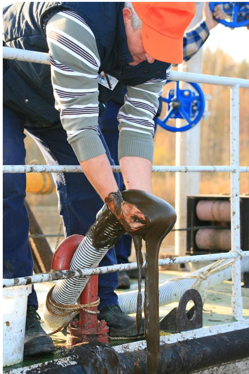
Рисунок 2.20 - Выход сапропеля из контрольного патрубка земснаряда оснащенного пневматическим камерным насосом (ПКН)
